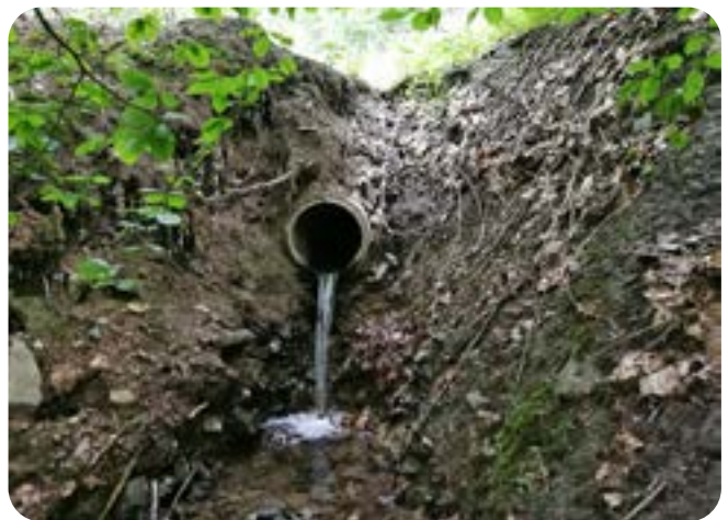
Abb. 2: Absturz infolge rückschreitender Erosion: Insbesondere bei Hochwasserspitzen erodieren am Auslauf der Verrohrung die Gewässersohle sowie angrenzende Uferbereiche. Es bildet sich im Laufe der Zeit ein für wassergebundene Organismen unüberwindbarer Absturz. Die Aufwanderung in die Gewässeroberläufe ist für diese Arten dann nicht mehr möglich (Foto: Bernd Schock)
