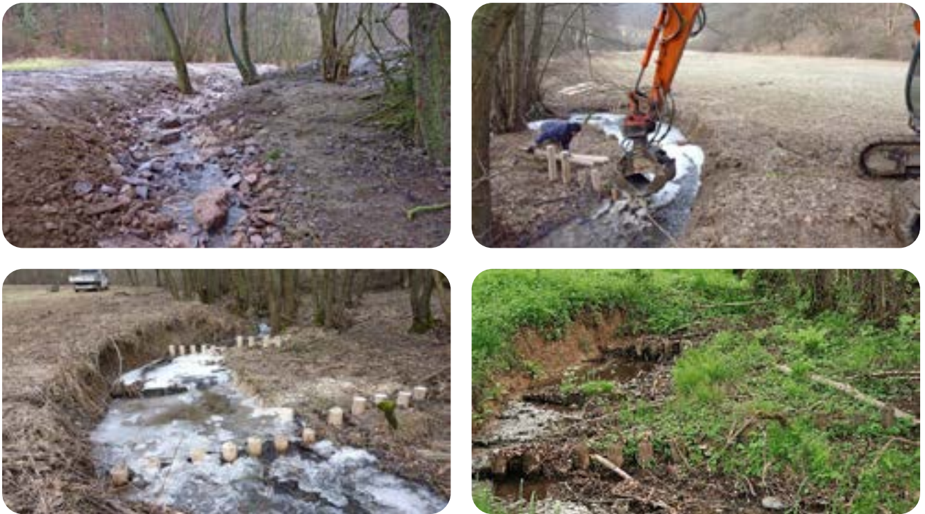
Abb. 10: Keßbach-Brackenwiese KB-1 bis KB-4; (o. li.) KB-1: Renaturierter Gewässerabschnitt unterhalb eines Wededamms mit neu angelegter Furt im Hintergrund oben. Im weiteren Bachverlauf Nivellierung des Gefälles und Sicherung des Bachbettes mit einer Steinschüttung; (o. re.) KB-2: Bachlauf im Bereich des Wiesengrundes eingetieft. Einbau von Sohlrechen aus unbehandelten Eichenrundholz-Pfählen, jeweils in Dreiergruppen abschnittsweise; (u. li.) KB-3: Fertig eingebaute Eichenpfähle; (u. re.) KB-4: Aufsedimentierung (Fein- und Grobsediment, Treibholz) – Situation nach 10 Jahren
