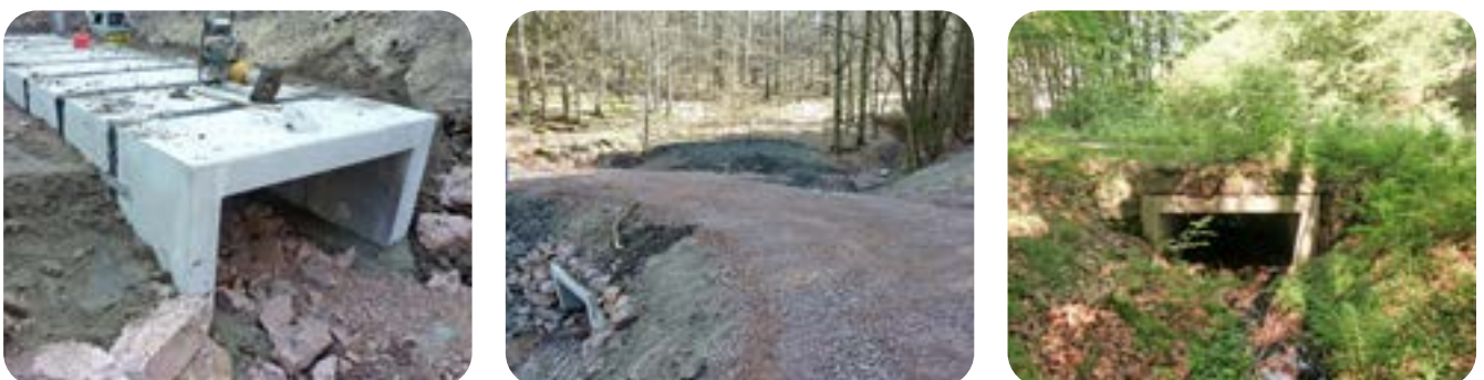
Abb. 11: Keßbach-Bringhäuser BS-1 bis BS-3; (li) BS-1: Rahmendurchlass (Kastenprofil) auf Streifenfundamenten gelagert; (mi.) BS-2: Wegeplanum über Rahmendurchlass; (re.) BS-3: Einlaufseite des Rahmendurchlasses mit intakter Gewässersohle nach 10 Jahren
