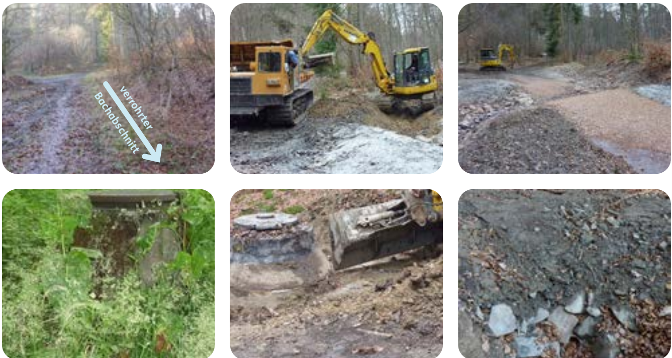
Abb. 5: Mittleres Heimbachtal – Schergraben HB-1 bis HB-6; (o. li.) HB-1: Ehemaliger Bachlauf parallel zum Fahrweg unterirdisch verrohrt; (o. mi.) HB-2: Weiter oberhalb der Verrohrung Gestaltung des Bachbettes mit Minibagger und Raupendumper; (o. re.) HB-3: Rückverlegung des Heimbachs in das alte Bachbett, Furanlage Wanderwegefurt im Bereich der Bachkreuzung; (u. li.) HB-4: Kopf eines Revisionsschachtes – stört das natürliche Landschaftsbild der Bachau; (u. mi.) HB-5: Rückbau der oberirdischen Teile eines Revisionsschachts; (u. re.) HB-6: Prüfstelle für das Hochspeicherbecken: mit KG-Rohr gefasster Quellaustritt vor der Renaturierung
