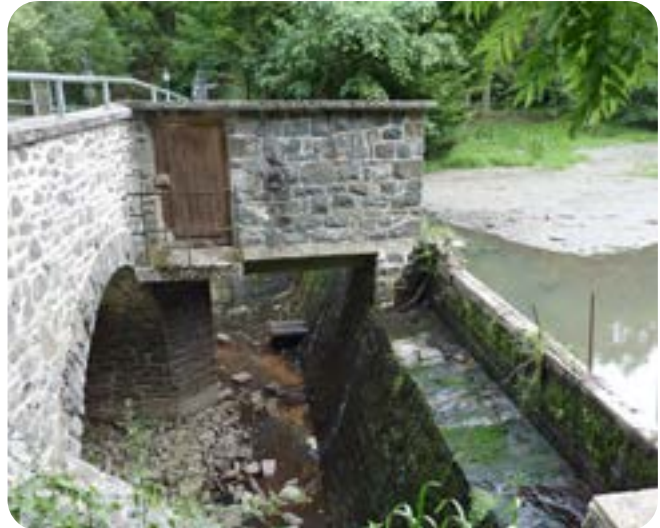
Abb. 13 WRRL 1: Banfwehr im Übergang der Banfemündung in die Edertalsperre
