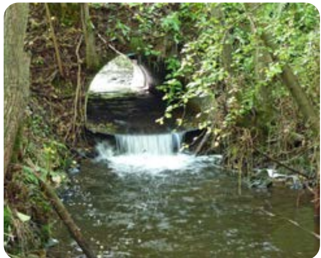
Abb. 13 WRRL 2: Amcro-Thyssen-Durchlass – Absturz hinter dem Auslauf verhindert die Durchgängigkeit für wassergebundene Lebewesen bachaufwärts
