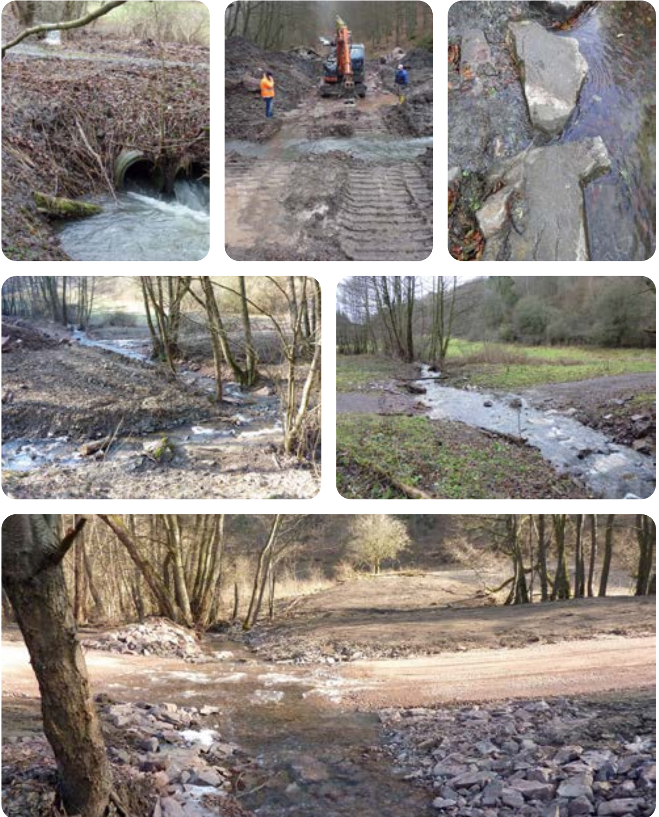
Abb. 7: Große Küche-Keßbach KK-1 bis KK-6; (o. li) KK-1: Vor Renaturierung – Wegedamm mit bei Hochwasser erheblich zu kleiner Doppelverrohrung, bei Niedrigwasser Abstürze an den Rohrausläufen; (o. mi.) KK-2: Einbau von Bruchsteinen zur Furtbegrenzung oben und unten, links zwischen Bagger und Person bereits fertig eingebaut. Im Vordergrund Bypass für Bachwasser während der Arbeiten; (o. re.) KK-3: Gut passierbare, wackelsichere Trittsteine; (mi. li.) KK-4: Im Vordergrund der Keßbach – auch an diesem Abschnitt wurde eine Verrohrung entfernt (ehemaliger forstlicher Rückeweg). Hinten links diagonal der Bach „Große Küche“ mit Furt, aus dem gleichnamigen Wiesengrund kommend, in den Keßbach mündend; (mi. re.) KK-5 Renaturierungsstelle mit fast fertiger Furt (Trittsteine fehlen noch); (u.) KK-6: Keßbachtalae – Küchenbach mündet in den im Verlauf der Erlengalerien fließenden Keßbach im Bildhintergrund. Fertige fahrbare Furt durch den Küchebach mit Ufersicherung. Hinten Mitte zwischen den Erlengalerien, teilweise Rücknahme eines ehemaligen Rückewegedamms mit Entnahme einer Verrohrung und Gestaltung der Bachaue
