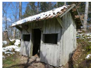
Foto H 8: Historische Schutzhütte am Hochstein (Achim Frede)
